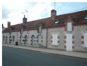
Briques colorés en losange / **Matériau traditionnel pierre** (calcaire, craie, silex) : murs et soubassements en moellons, encadrements et chainages d'angle en pierre de taille
